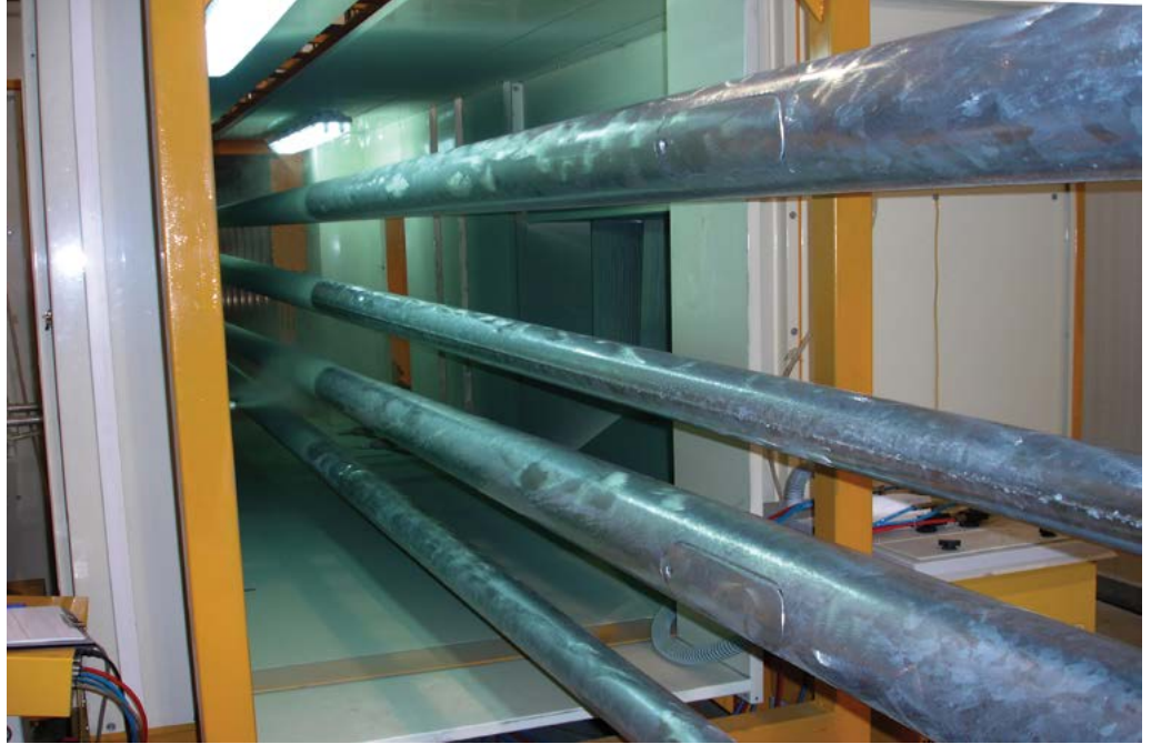
Εισαγωγή στο χώρο ψεκασμού πούδρας
